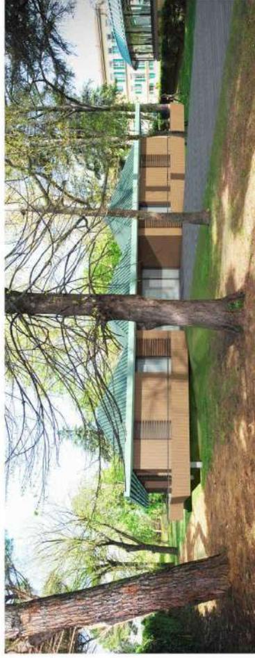
La prima proposta risolveva la facciata attraverso delle aperture a tutta altezza che creano un ritmo di alternanza, all'esterno tra legno e vetro e all' interno tra libreria e tagli sull'esterno. Questo tipo di aperture può funzionare anche come porte finestre e permettere di creare una connessione diretta tra interno ed esterno. La struttura ipotizzata è in pannelli portanti in legno, tipo xlam.
