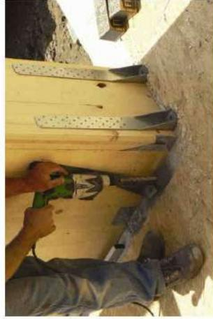
Fig. 3: Hold-down sugli spigoli dell'edificio ed in corrispondenza delle aperture, di presidio al sollevamento.
